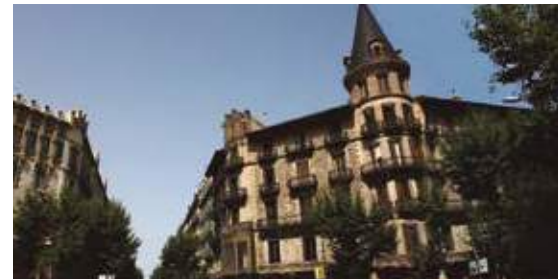
CASA BURÉS (BARCELONA). 800m 2 verlegte Fläche
