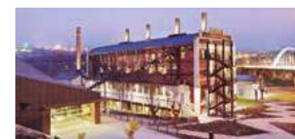
ENERGIEMUSEUM. 5.010m 2 verlegte Fläche
