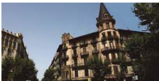
CASA BURÉS (BARCELONA). 800m 2 instalados
