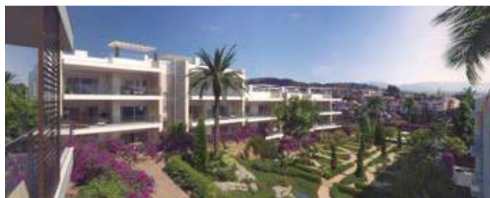
SON QUINT HOMES (PALMA DE MALLORCA). 10.000m 2 instalados
